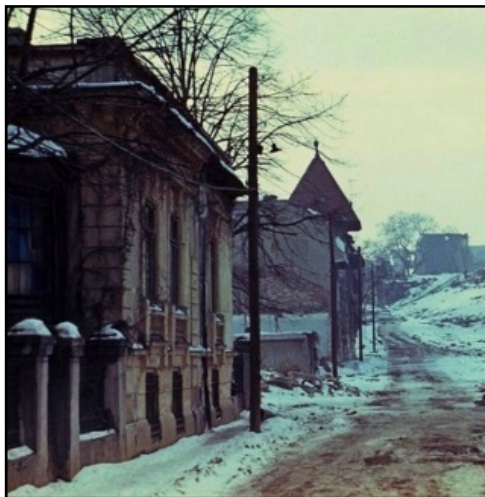
Fig. 9. Strada Lăzureanu, în demolare
